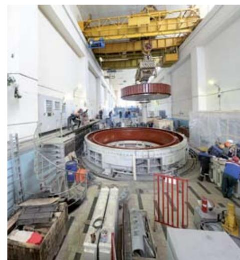
На гидроагрегате ст. № 3 завершены монтажные работы. После окончания наладки вспомогательного оборудования гидроагрегата на сухой спиральной камере затоплена водой проточная часть гидротурбины. Пуско-наладочные работы находятся на завершающей стадии. В середине июля планируются выполнить комплексные испытания.
