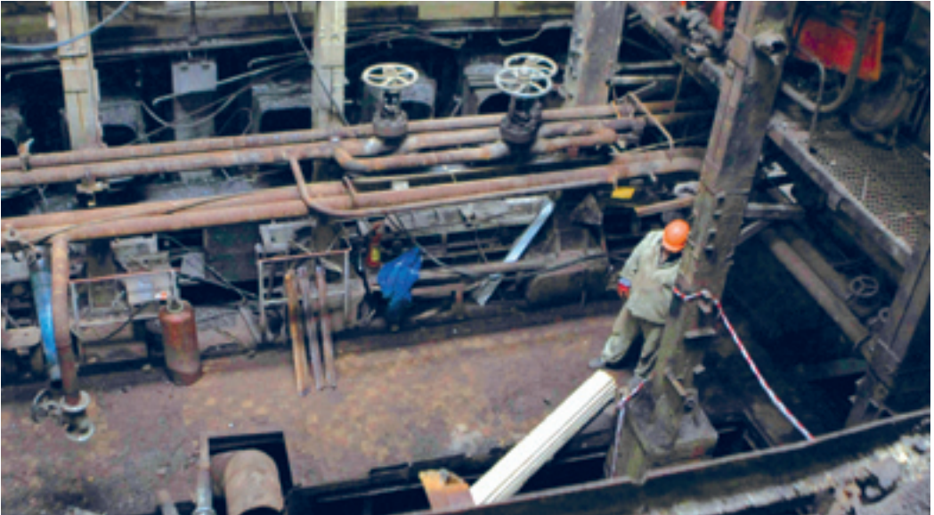
Котел ПВК-1 в ремонте
