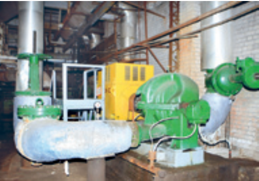
Сетевой насос после ремонта
