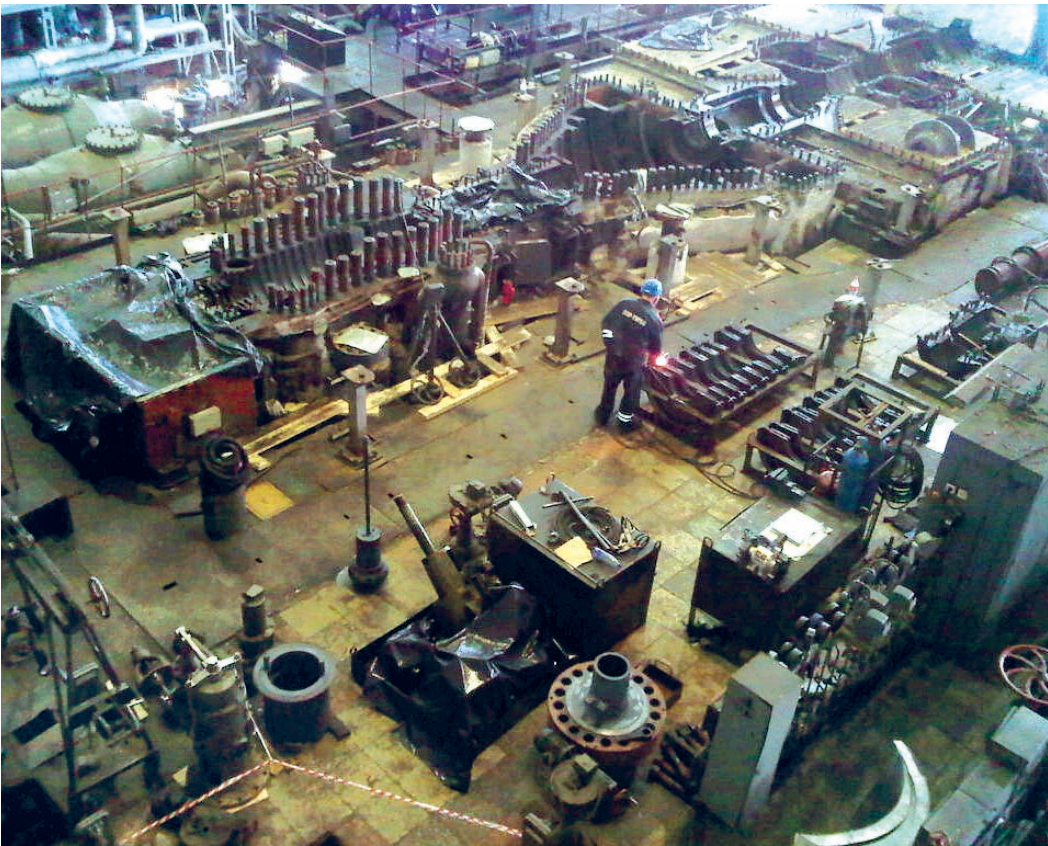
Капремонт блока №5 Северной ТЭЦ ТГК-1: общий вид площадки
