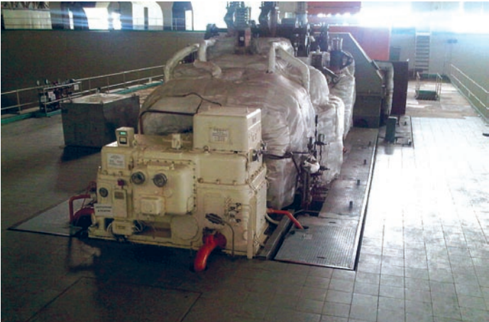
Капремонт блока №2 ТЭЦ-27 Мосэнерго: завтра начало ремонта
