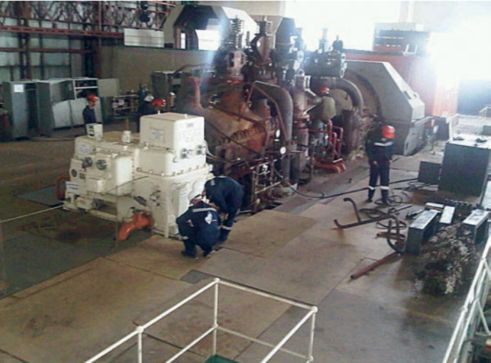
Капремонт блока №2 ТЭЦ-27 Мосэнерго: ремонт начался
